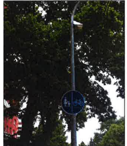
Unauffällig und doch äußerst effizient: In Norderstedt gehören diese WLAN Access Points ab sofort zum Straßenbild
